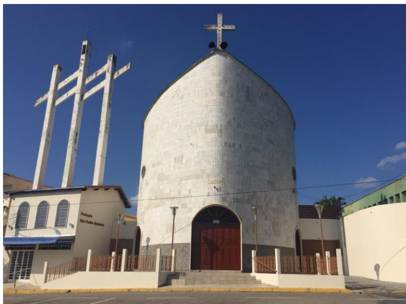
Igreja de São Pedro Apóstolo Crédito: http://arqaparecida.org.br
