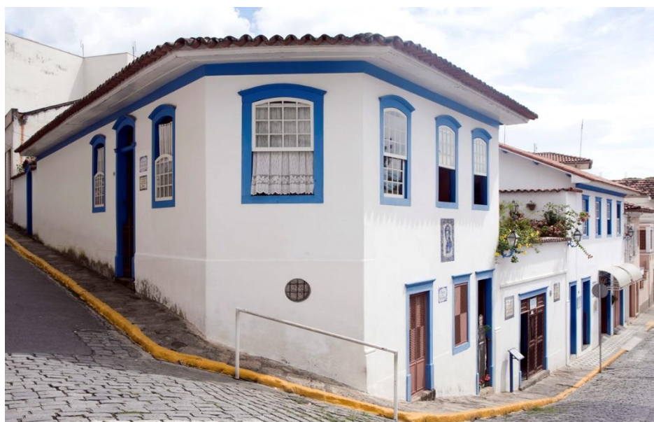
Casa de Frei Galvão
