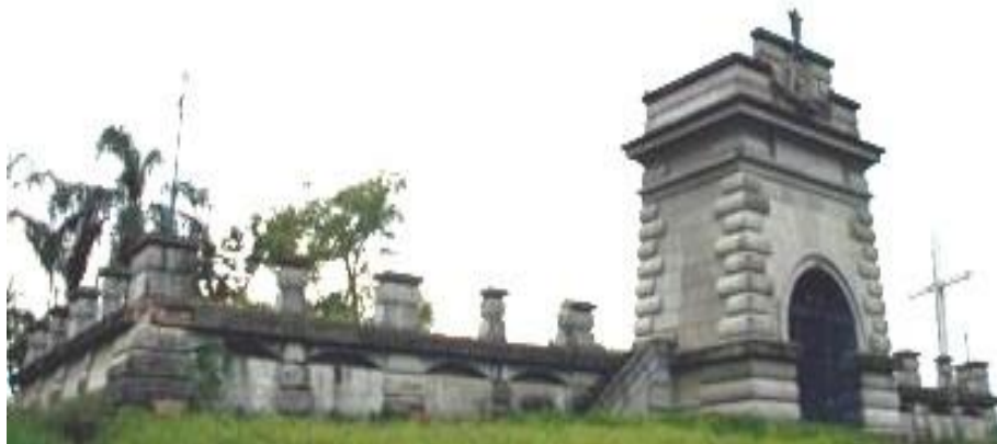
Caixa D'água do Portal.
